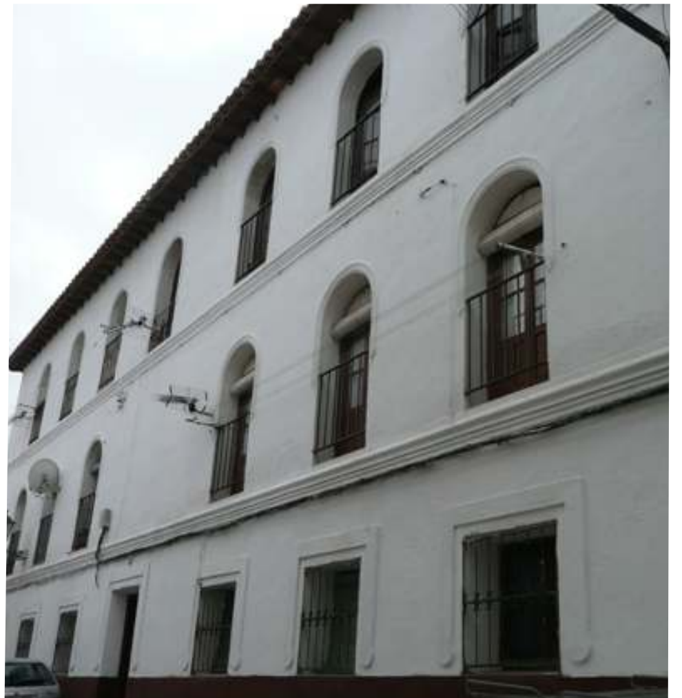
Viviendas sociales de Santa Catalina, tras la reparación.
