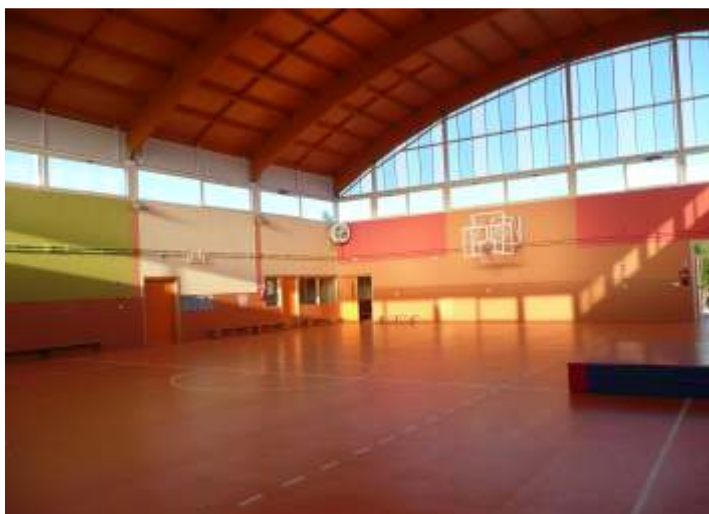
Imagen del interior del nuevo gimnasio
