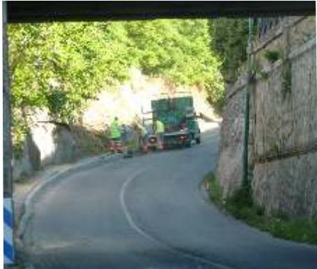
Inicio de las obras, bajo el puente de La Estación
