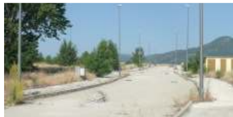
Estado actual del SAU-5
