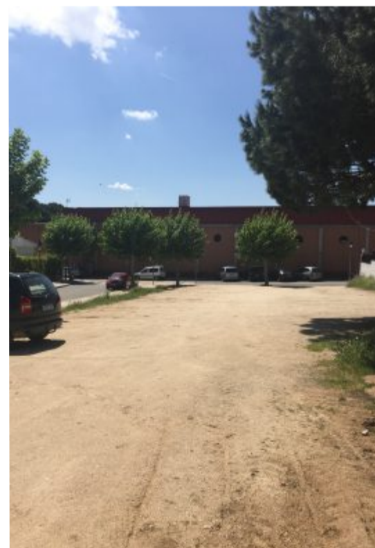
Parcela que va a ser pavimentada y adecuada como aparcamiento, frente al pabellón polideportivo.
