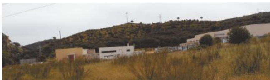
Imagen de la potabilizadora, construida junto a la M-501 que dará servicio a los ciudadanos de San Martín y Pelayos.
