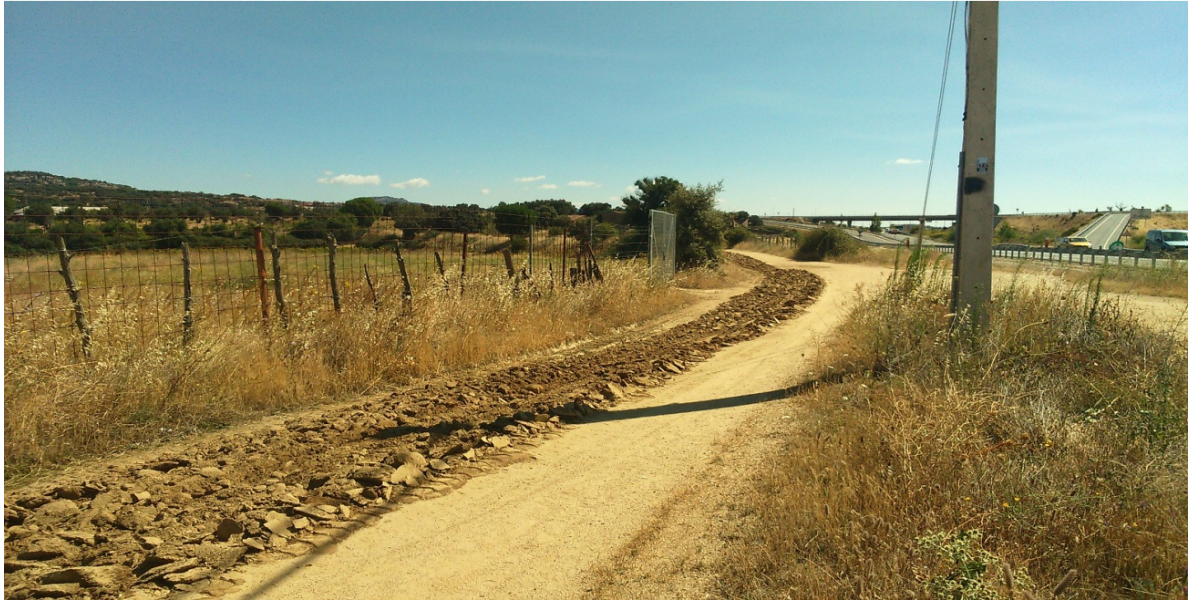
Labores de reparación del camino de la Vía, a su paso por "La Mata".
